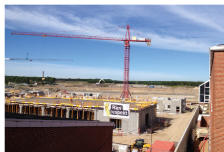
Medarbejderne på byggepladsen ved Skejby Sygehus viser deres sympati for og solidaritet med rengøringsmedarbejdernes kamp for bedre forhold på arbejdspladsen. Det store banner kunne tydeligt ses fra sygehusdirektørens vindue.
